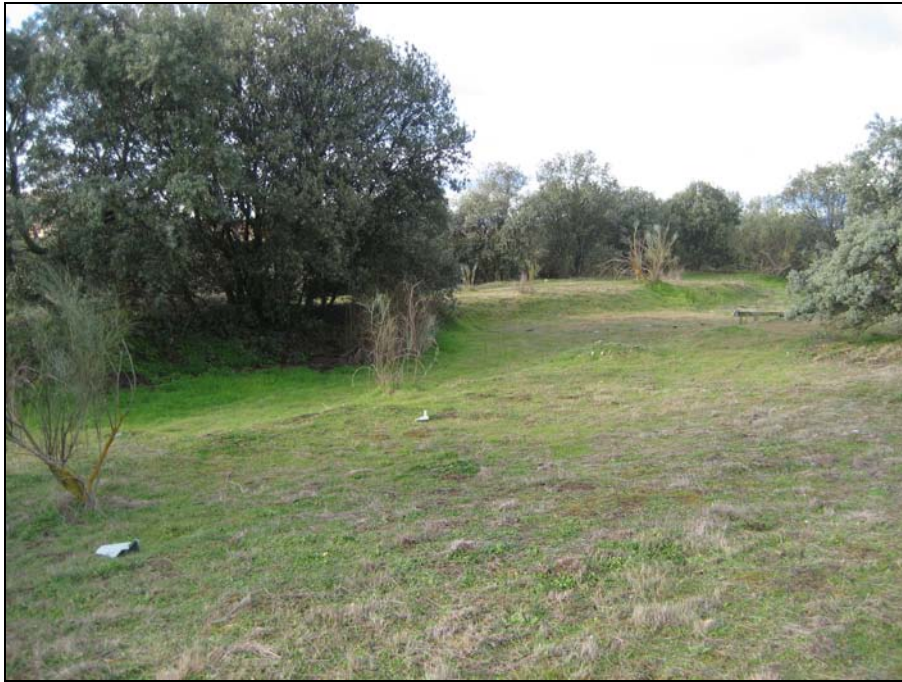
Fig. 9. Traza del Canal del Guadarrama al Norte del acueducto de la Carrascosa.
