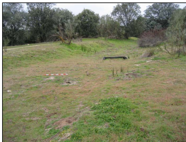
Traza del Canal próxima al acueducto.
