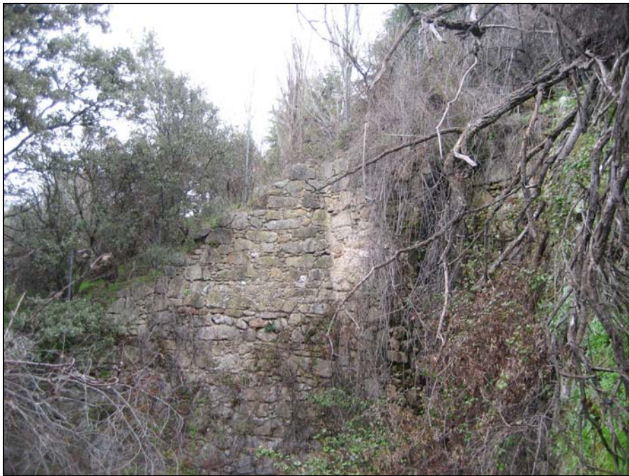
Fig. 10. Acueducto sobre el arroyo de la Carrascosa.
