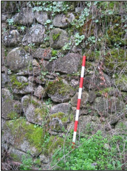
Fig. 11 y 12. Detalle del paramento del muro de aguas abajo del acueducto sobre el arroyo de la Carrascosa.
